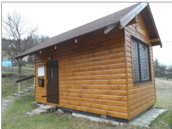
Príloha č.1 - oprava unimobunky
